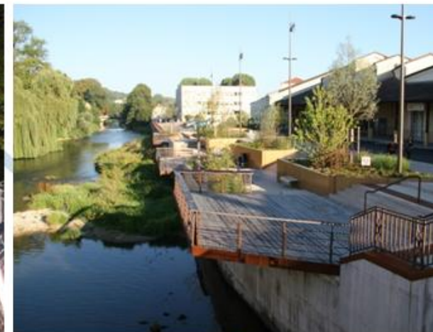
Aménagement des berges de l'Ormain, Gondredourt-le-Château (55)
